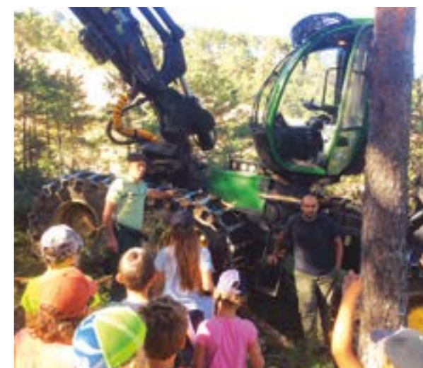
Les écoliers de Séranon (06) rencontrent le conducteur d'engins forestiers du chantier avec l'ONF
