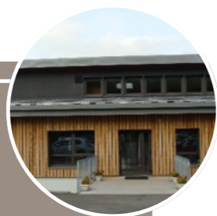
Siège social de la communauté de communes des portes du Haut-Doubs (25)
